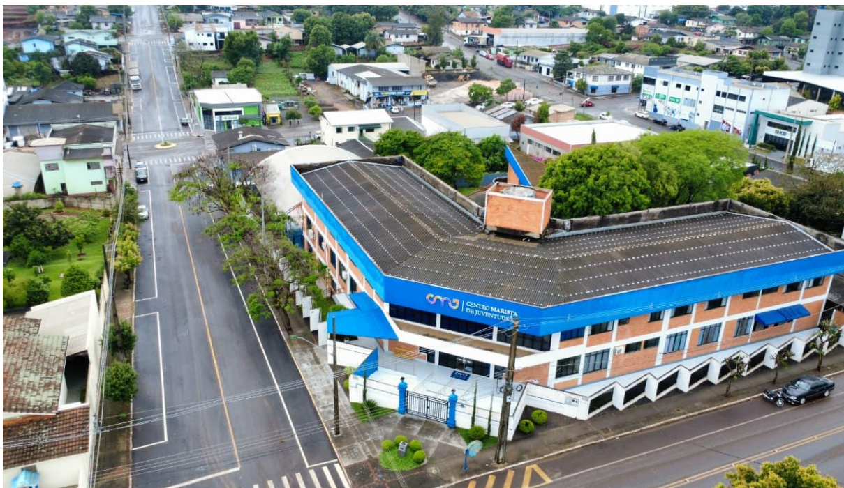
Foto 03: Foto aérea vista superior
